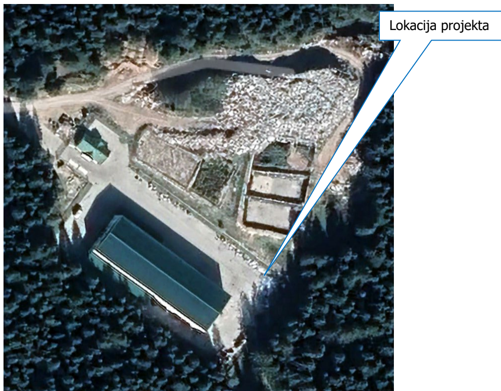
Slika 2.2. Uže okruženje bazne stanice
